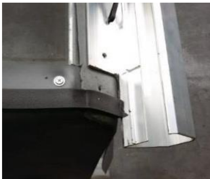
Rys. 57 Przykład podęcia profilu krawędziowego
